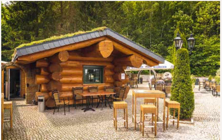
Das neu errichtete Blockhaus. Ein echter Hingucker.
